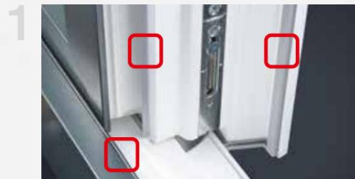
**3 umlaufende Dichtungen** sind ohne Aufpreis erhältlich und verhindern das Eindringen von Wasser und Schall.
