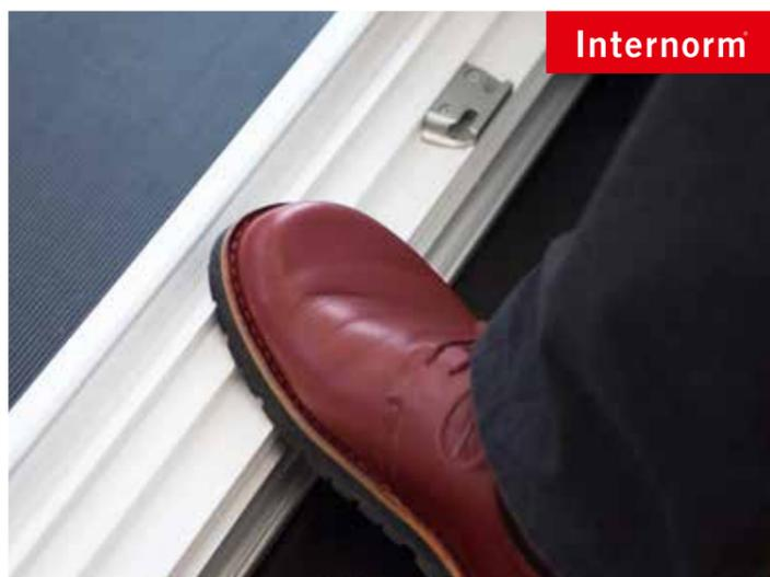
Mitteldichtung bei Internorm nicht am Rahmen sondern am Flügel
